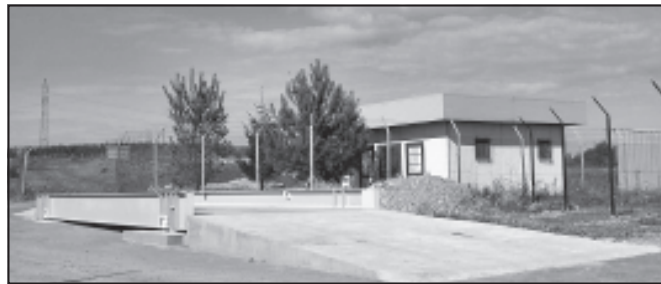
Składowisko odpadów komunalnych
