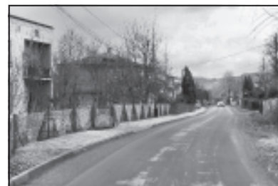
ul. Podgórska – nowa nawierzchnia i chodnik
